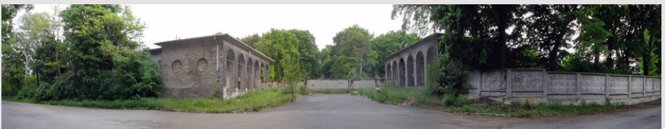
Abb.1: Die Wachgebäude der Kasernenanlage (links Ost-, rechts Westwachgebäude)
