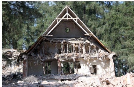
Abb.5: Ruine von Haus 15
